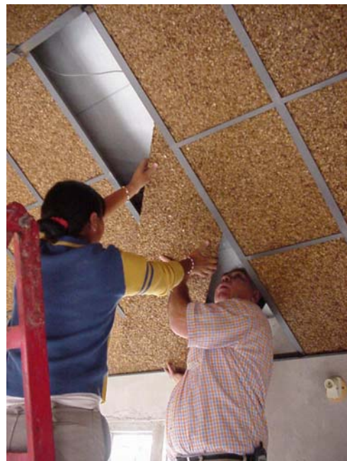
Fig 1 y 2: Colocación de placas de cielorraso de cáscaras de maní
